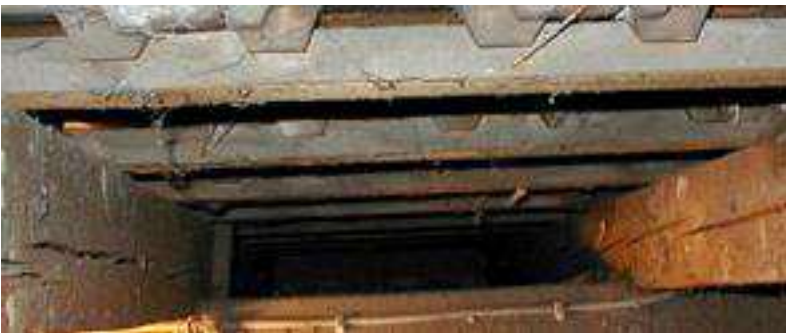
Hohlräume zwischen den Sparren
