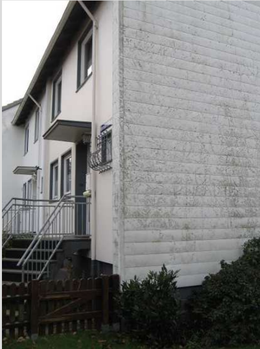
Ausgangssituation: Ungedämmtes Gebäude
