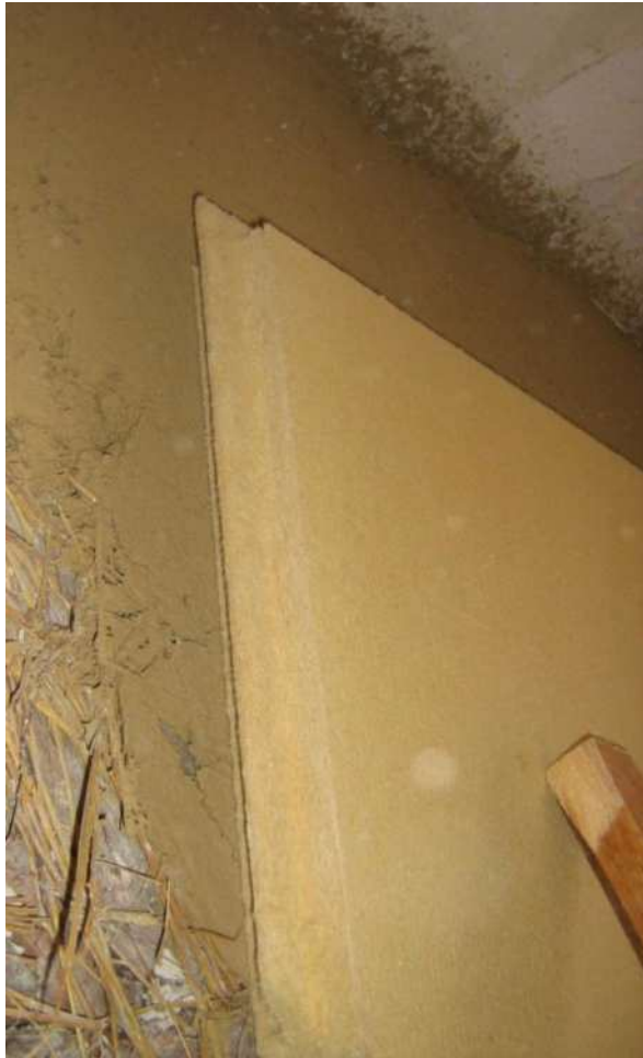
Weichfaserplatten werden in den feuchten Lehm gedrückt
