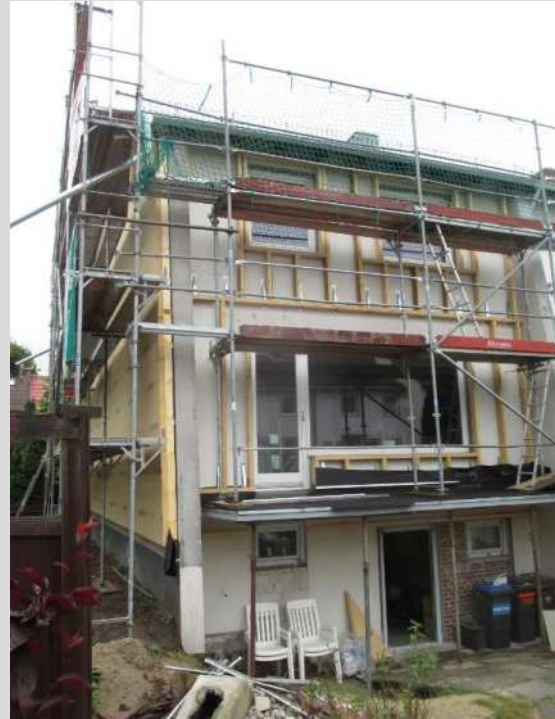
Erster Schritt: Lattung anbringen als Abstandshalter
