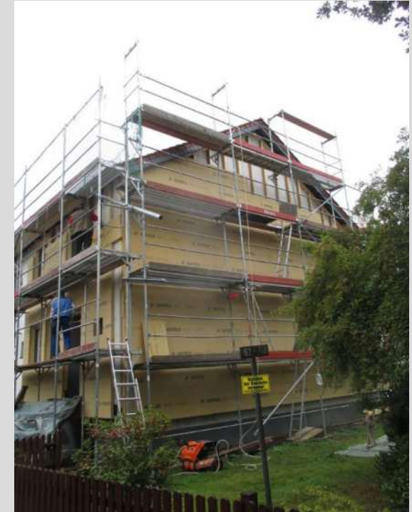
Zweiter Schritt: Holzweichfaser-Platten als äußere Hülle
