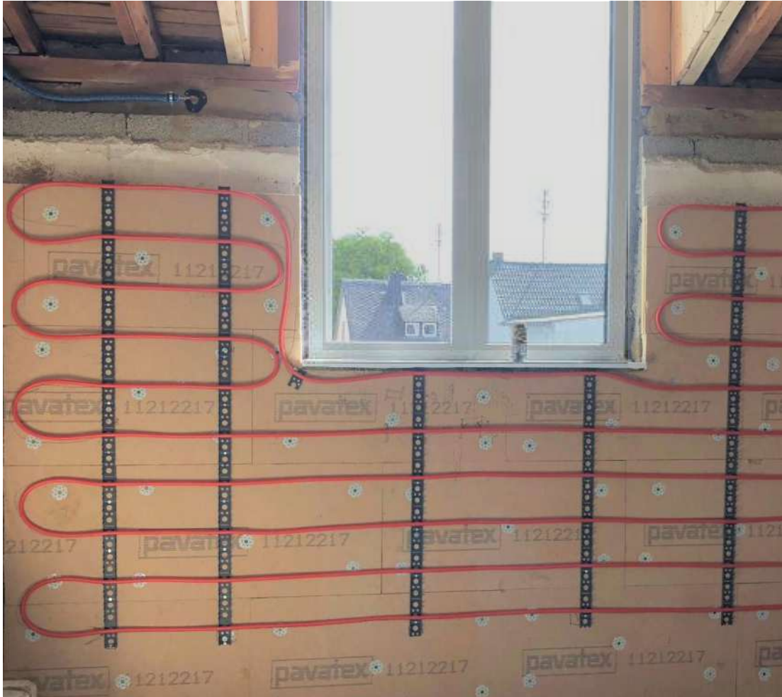
WEM Wandheizung auf Holzweichfaser und abschließend Lehmputz
