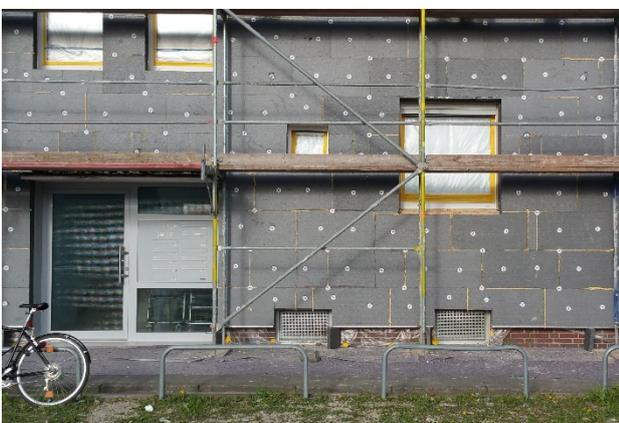
Außendämmung mit Polystyrol
